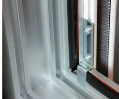
Pose sur dormant de fenêtre – Fixation sans perçage avec pattes métalliques
